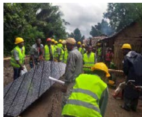
Les travaux de réfection des trois ponts s'achèveront en juin 2022.
