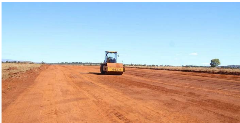
Une route de 32 mètres de large a été terrassée.
