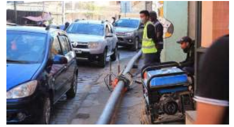
Remplacement des conduites d'eau en cours à la Haute Ville.
